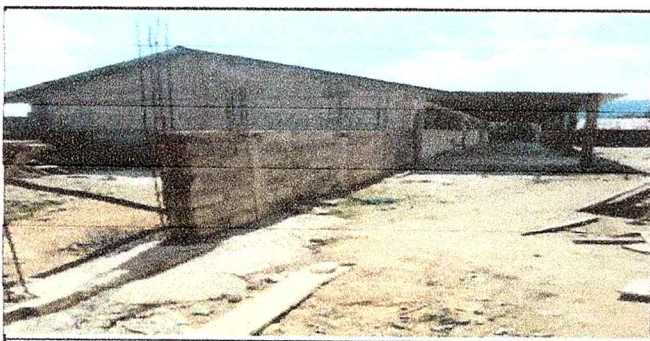
Foto 5: pintura en interior y exterior de las cuatro aulas modulo 2
