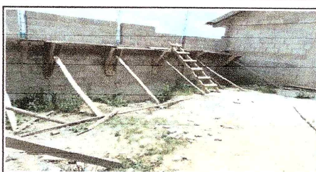
Foto 4: Instalacion de piso interior y exterior modulo 2
