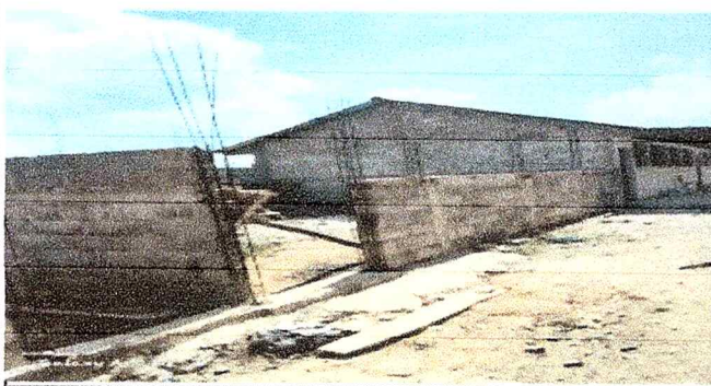
Foto 3: Instalacion de puertas y ventanas modulo 2
